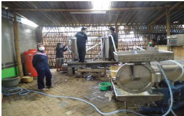
Gambar 15. Proses Install Sistem Komponen Pencuci Garam Basah.
